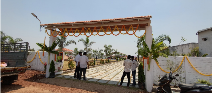
ಕುಟುಂಬದ ಮೇಲಿನ ಪ್ರೀತಿ ಹಾಗೂ ನಿರ್ಮಾಣವಲ್ಲ ತಾಯಿಯ ಪ್ರೀತಿ, ತ್ಯಾಗ, ಮತ್ತು ಉಳಿಸಿಕೊಳ್ಳುವ ಉದ್ದೇಶದಿಂದ ಗಾರ್ಡನ್ ನಿರ್ಮಿಸಲಾಗಿದೆ ಎಂದು ಕುಟುಂಬದವರು ತಿಳಿಸಿದ್ದಾರೆ. ಇದು ಕೇವಲ ಒಂದು ಗಾರ್ಡನ್ ಸಮಾಜಮುಖಿ ಚಿಂತನೆಗಳನ್ನು ಸದಾ ನೆನಪಿನಲ್ಲಿ ಇಟ್ಟುಕೊಂಡು ದಾಸರಿ ಹಾಗೂ ಆಜಯನಾಥ ದಾಸರಿ ಅವರ ಈ ಕಾರ್ಯಕ್ಕೆ ಎಲ್ಲೆಡೆ ಸಾರ್ವಜನಿಕರಿಂದ ಮೆಚ್ಚುಗೆ ವ್ಯಕ್ತವಾಗುತ್ತಿದೆ.
